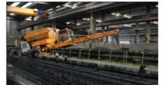
Le coulage du béton
