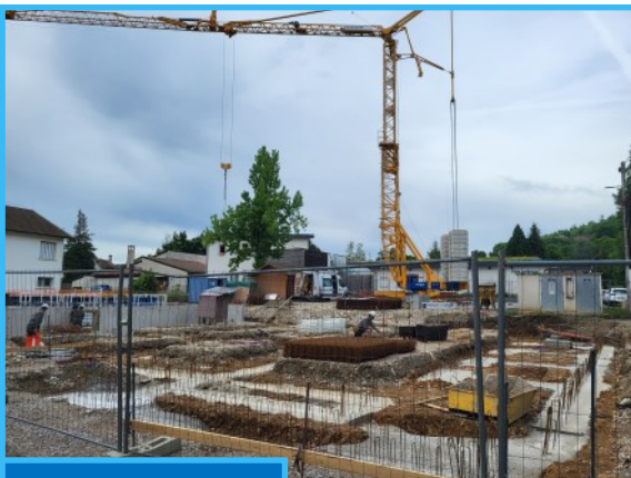
Début des travaux
