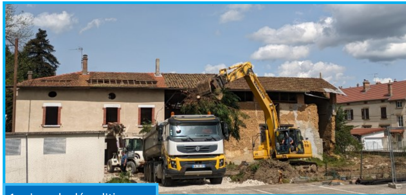
1er jour de démolition
