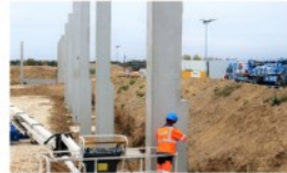
Le montage sur chantier
